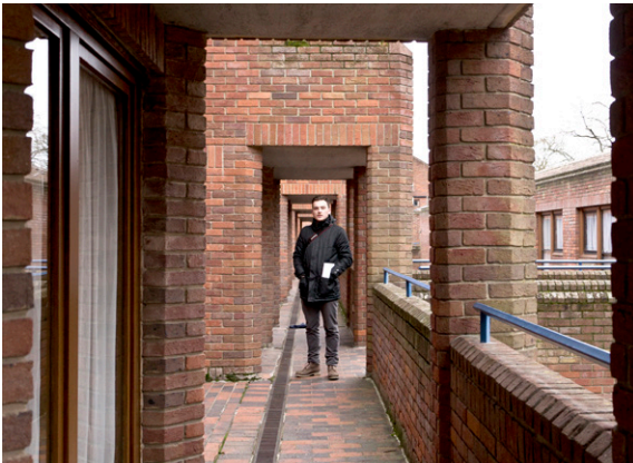
De galerij waarin de woningen worden ontsloten
