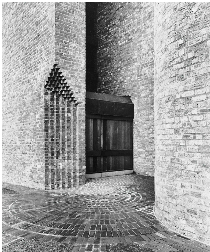
De verborgen kleine entree wordt door het gemetselde detail geaccentueerd in de grote geopende stenen doos van St. Bride's
