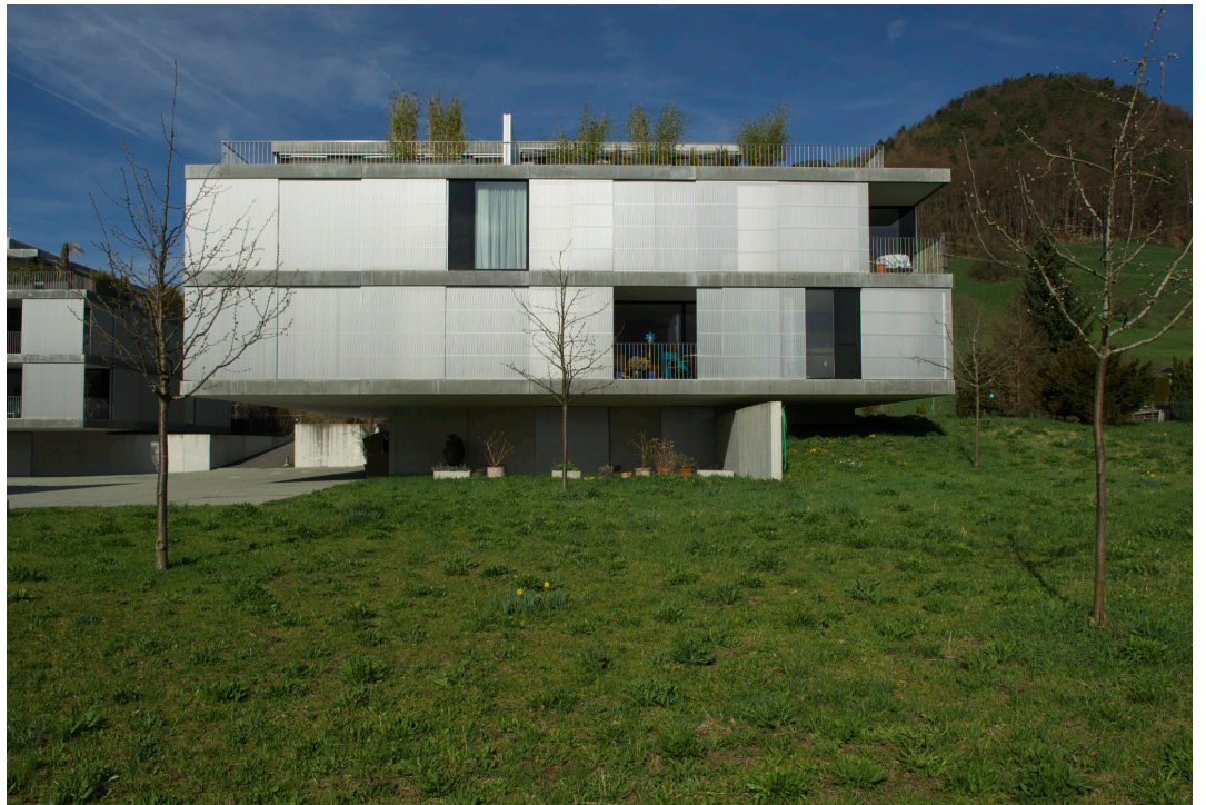
Woningbouw Chottegässli, Bolligen 2003-2007
